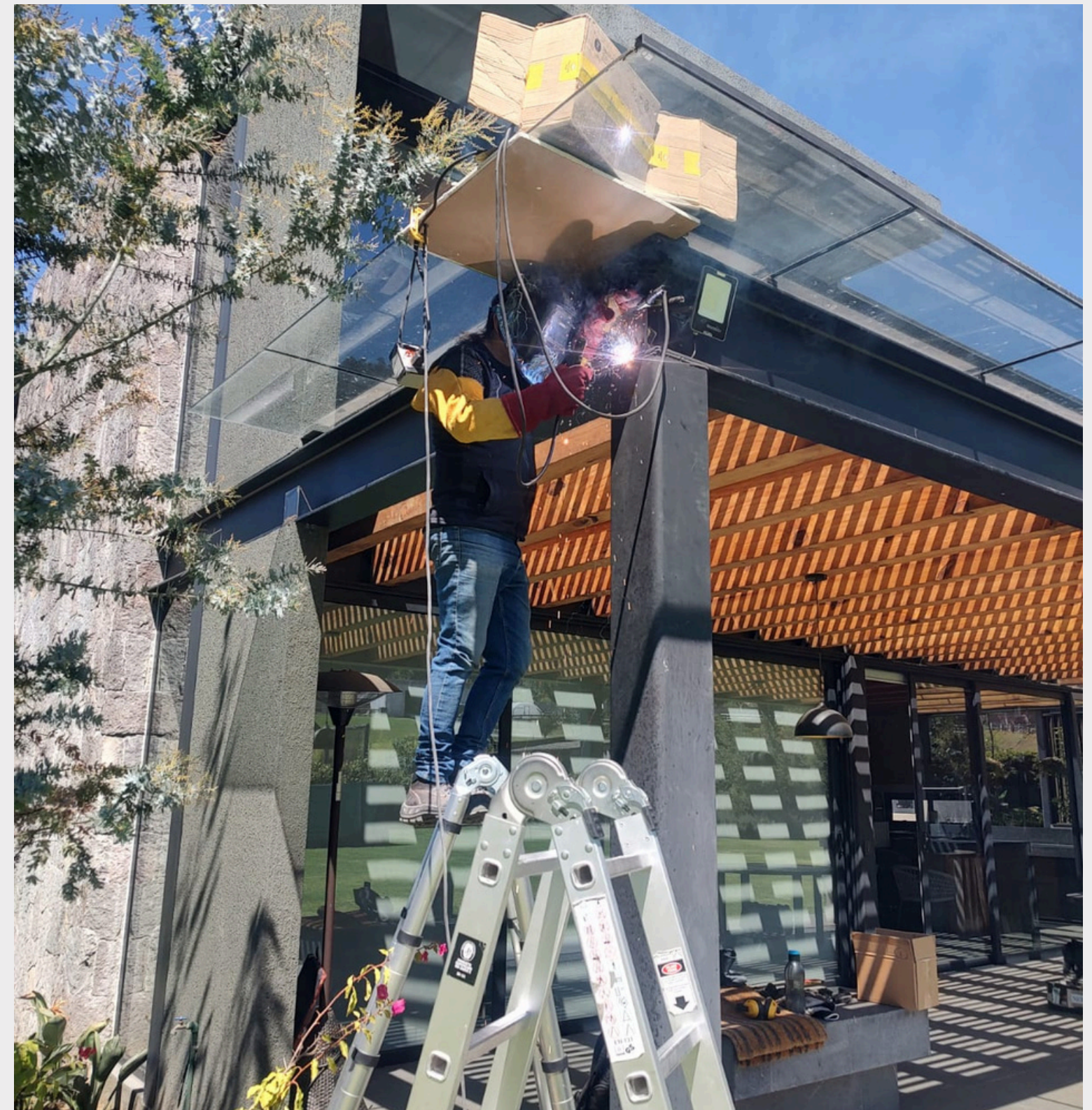
Ilustración: celosía motorizada + refuerzo estructural de herrería. Proyecto: casa Avándaro, Edo de México.
